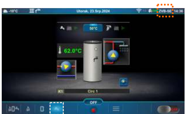
Zaslon potrošne tople vode (PTV) (ZVB-SE)
